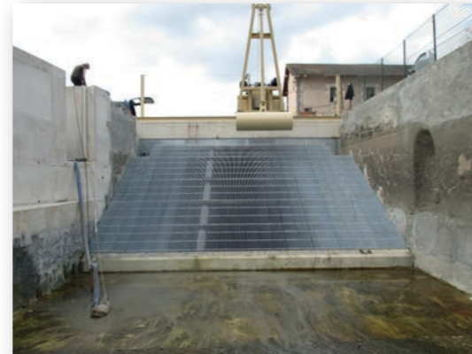
Grilles à 26° par rapport à l'horizontale avec exutoires de dévalaison
